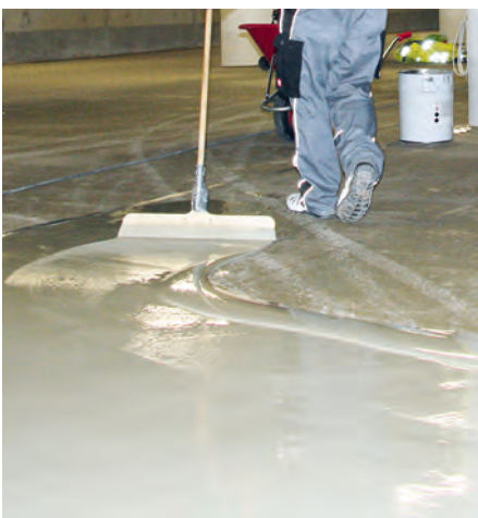
Abb. 12: Verteilen einer PU-Beschichtung mit dem Raketel
