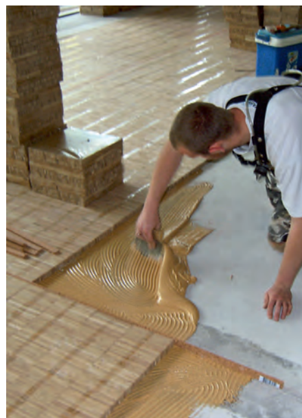
Abb. 8: Verlegen von Parkett in PU-Klebstoff
