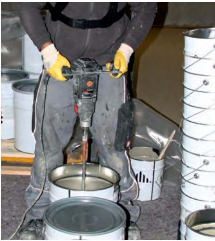
Abb. 11: Mischen von 2K-PU-Beschichtung mit einem Rührquirl
